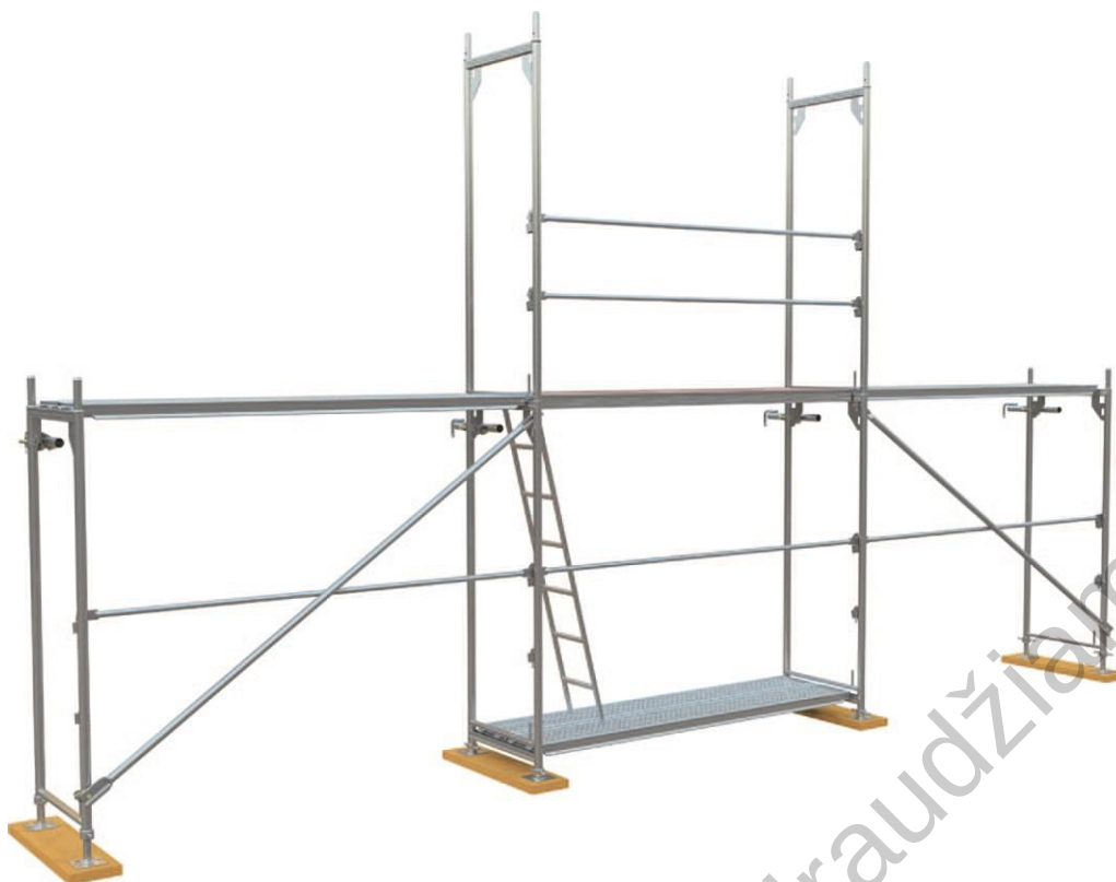
11 pav. Rėmų ir turėklų montavimas antro aukšto komunikacinėje vertikalyje
