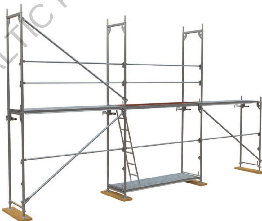
12 pav. Skersinės įstrižainės montavimas antroje aukšte
